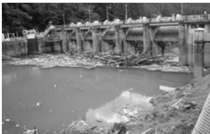
平成23年9月10日（土）九尾ダム
