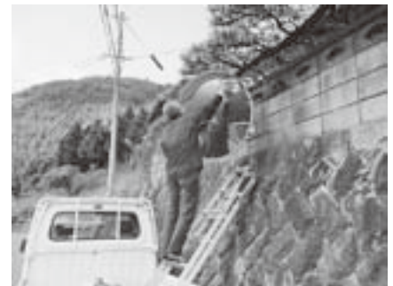
カーブミラー点検・清掃
