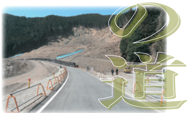
平成24年3月29日 応急工事完了
