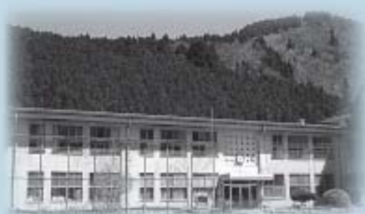
洞川小学校校舎
