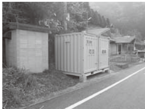
山西地区 防災備蓄倉庫
