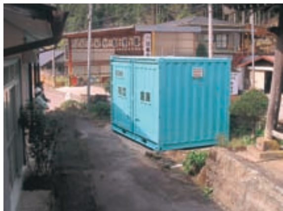
防災備蓄倉庫の設置（和田区）
