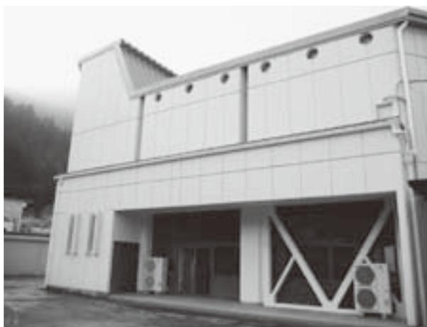
大ホールは窓部と舞台上部に鉄骨ブレスを設置、センター 1 階は建物内部の壁を耐震壁にし、地震に耐える構造となりました。
