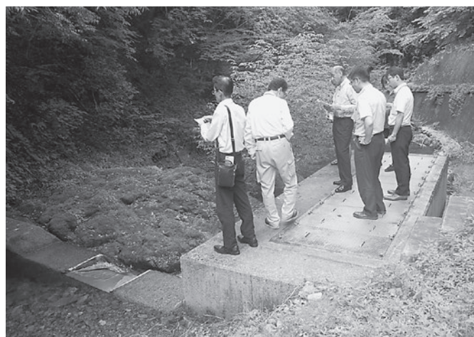
取水口を見学
