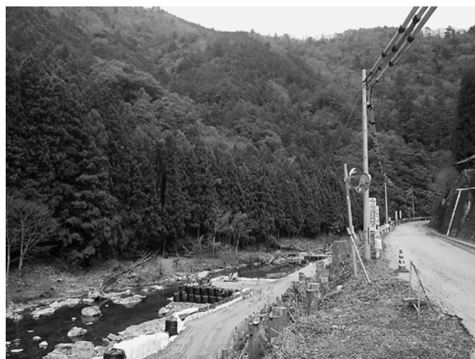
H30庵住地区 県道拡幅状況 ②
