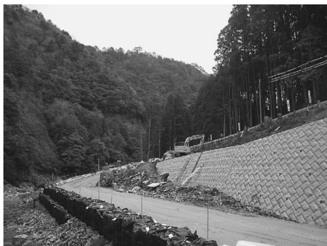
H30庵住地区 県道拡幅状況 ①
