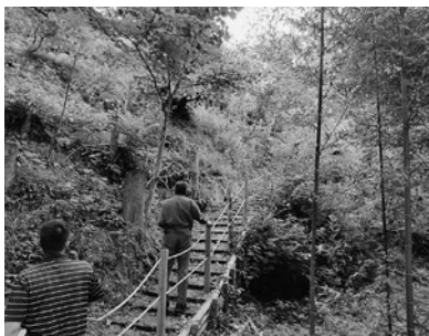
坪内遊歩道整備工事
