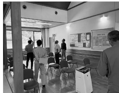
天川村保健福祉総合センター 空調機器設置改修工事
