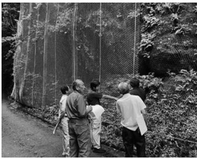
林道大橋線改良工事
