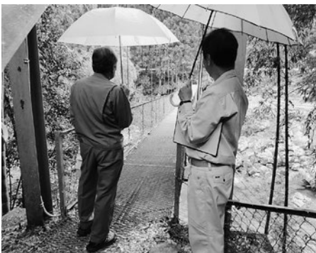
籠山吊り橋橋梁補修工事 （緑越事業）
