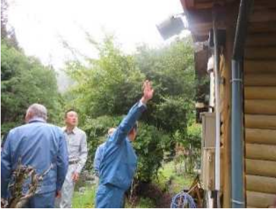
防犯カメラ 設置工事
