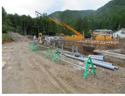
洞川温泉 ビジター センター 新築に伴う 造成工事
