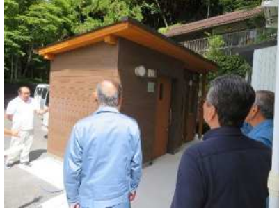
川合 公衆トイレ 新築工事
