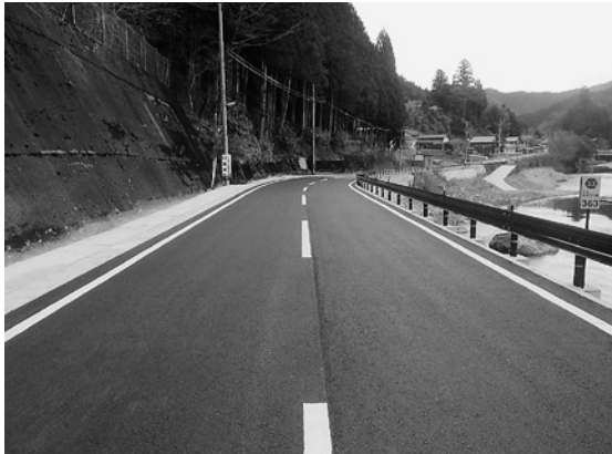
南日裏坪内工区
