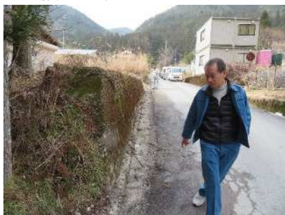
◎側溝改修、横断溝設置 （南日裏）
