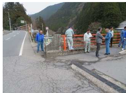
◎橋西詰の拡幅、欄干の塗装 （坪内区から要望）
