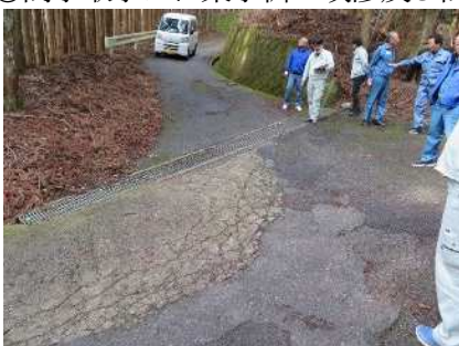
◎村道舗装、側溝改修（塩野）
