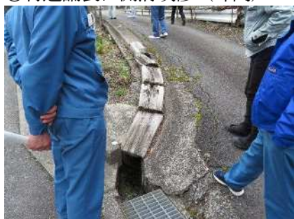
◎村道側溝の改修（庵住）
