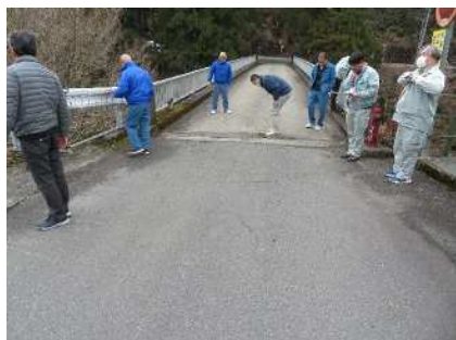
◎村道と橋梁の段差解消 （北小原）
