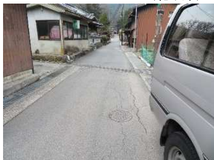
◎村道舗装、側溝改修（坪内）
