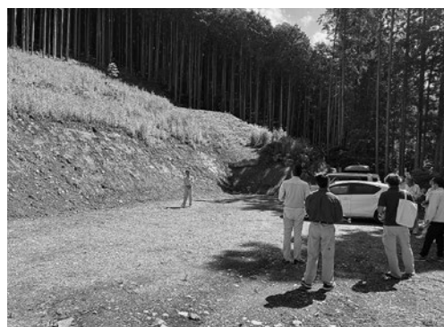
◀北角地内多目的広場整備 工事監査
