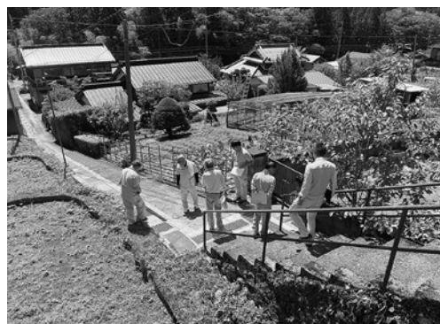
◀村道沢原五色線側溝改良 工事監査
