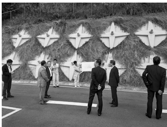
▲下市町伊豆での現場視察
