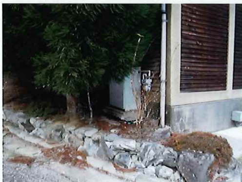
③ポンベハウス付近沈下
