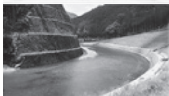
整備した河川護岸
