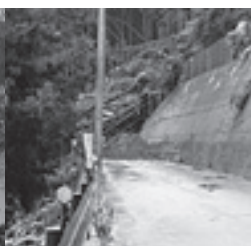
土砂崩れで道路が寸断
