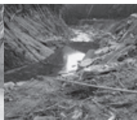
破壊された護岸
