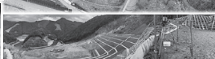
斜面からの土砂を押える押え盛土
