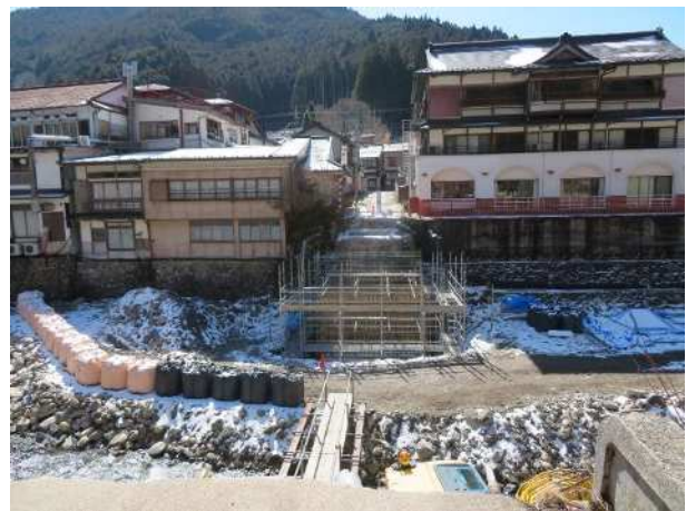
③ 橋梁補修工事：洞川八幡宮下の橋梁（無名橋）の床板等の損傷が激しいため補修工事を行っていました。
